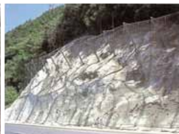
建築・土木用途で幅広く利用されている落石防護ネット
